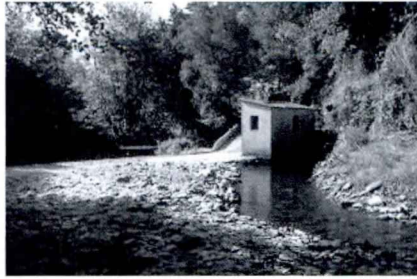
FIGURA 7. Captació d'aigües superficials a la presa de Viladecans, al curs alt de la Tordera. En la fotografia, presa el 12 de maig de 1999, s'observa com tot el cabal circulant és derivat cap al canal de captació, deixant el riu sec. (Foto: Marta Miralles)
